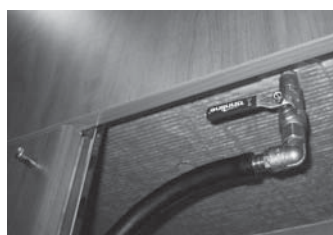
Lämpöaltaan tyhjennysventtiili
