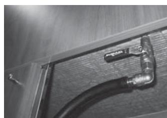
Lämpöaltaan tyhjennysventtiili
