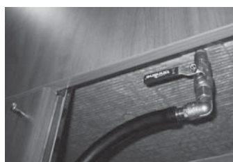
Lämpöaltaan tyhjennysventtiili
