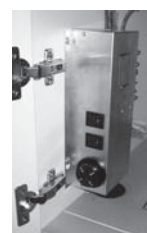
Lämpöaltaan virtakytkin ja termostaatti
