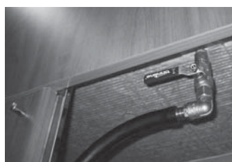
Lämpöaltaan tyhjennysventtiili
