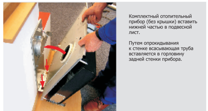
14 МОНТАЖ КАМЕРЫ ГОРЕНИЯ
