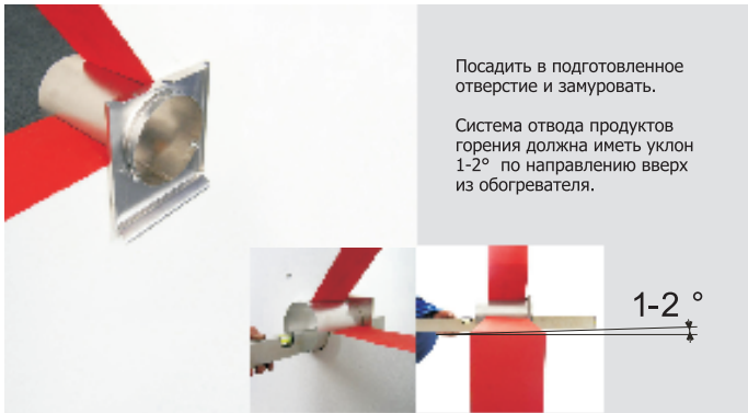
9 МОНТАЖ ЭЛЕМЕНТОВ ОТВОДА ПРОДУКТОВ ГОРЕНИЯ
