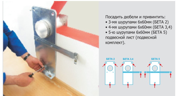
10 МОНТАЖ ЭЛЕМЕНТОВ ОТВОДА ПРОДУКТОВ ГОРЕНИЯ
