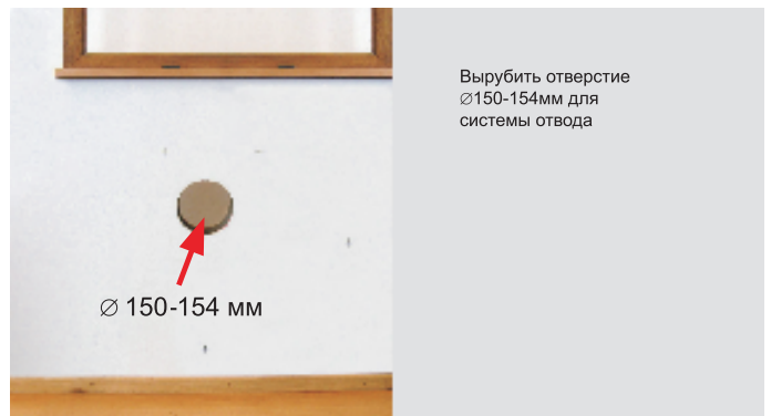
4 МОНТАЖ ЭЛЕМЕНТОВ ОТВОДА ПРОДУКТОВ ГОРЕНИЯ
