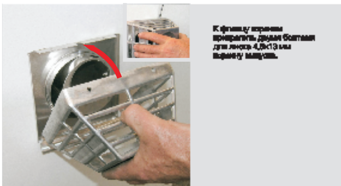
15 МОНТАЖ КАМЕРЫ ГОРЕНИЯ
