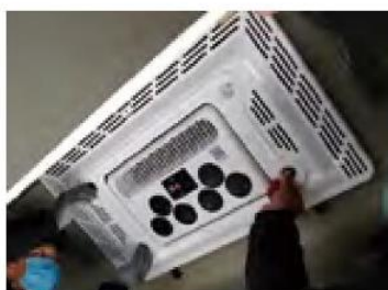
4. Закрепить кондиционер крепёжным швеллером, закрыть облицовочной рамкой
