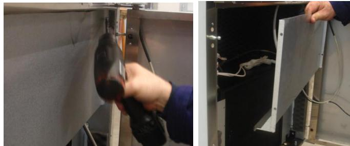
Удалить фиксирующие винты электрического щита.
