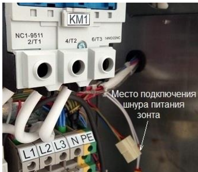
Рис.1 Подключение шнура питания зонта к колодке 45.7373.9005 пароконвектомата
