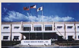
Hitachi Air Conditioning, Филиппины
