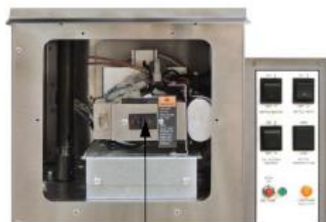
Авт. выкл. котла располагается за крышкой. Снять крышку для доступа к выключателю.
