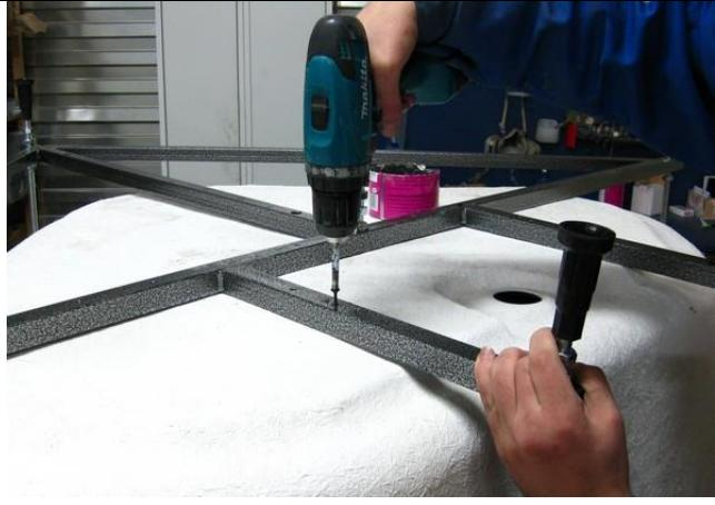
3. Зафиксируйте раму на днище ванны саморезами, входящими в комплект каркаса.
