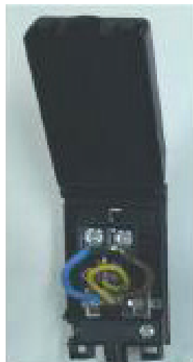
Рис. 2. Электрическое соединение кабеля прибора.
