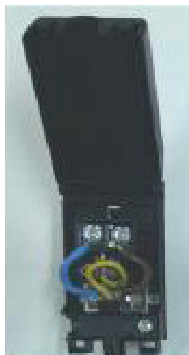
Abb. 2. Elektrischer Anschluss des Instrumentenkabels.
