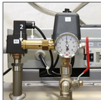
Рис. 17: Проверка предохранительного клапана
