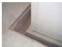
Dettaglio Scavo Excavation example
